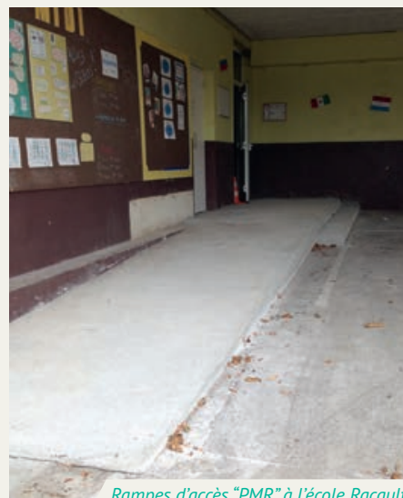
Rampes d'accès "PMR" à l'école Racault.
