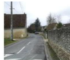
Murs en moellons
