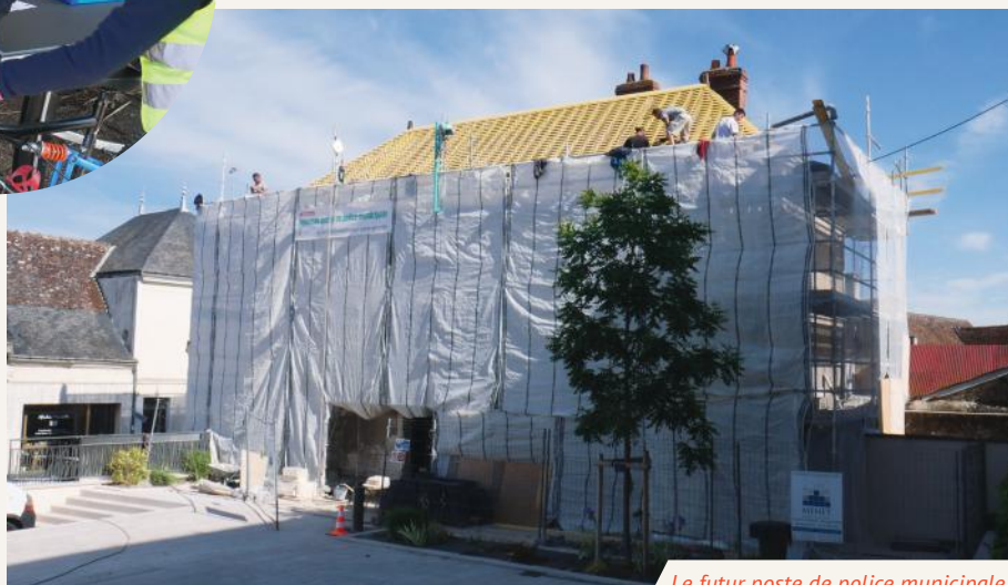
Le futur poste de police municipale.
